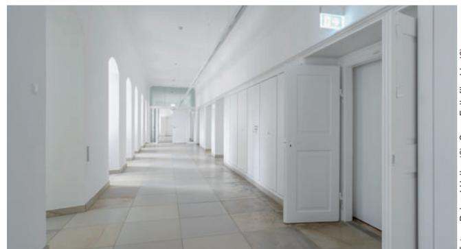
Seitlich wechseln sich restaurierte Einbauschränke und Türelemente ab. Gläserne Brandschutzelemente separieren die Flure in Brandabschnitte.
